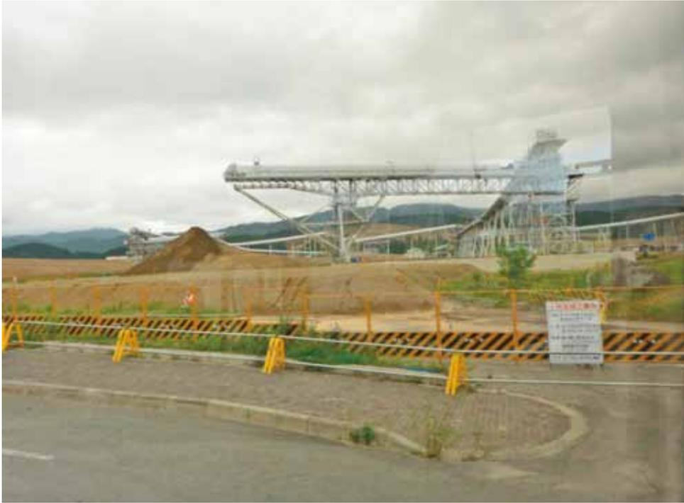
ベルトコンベアでの盛り土作業（陸前高田市）
