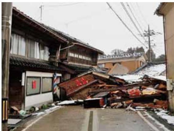
倒壊した家屋（石川県能登町）
