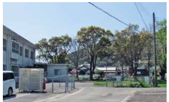
内原小学校の新館北側に校舎を増築
