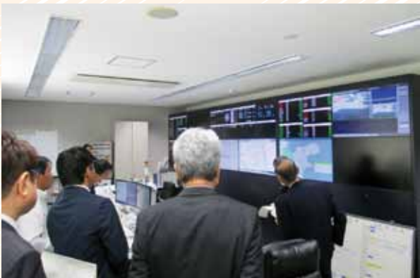
現在運用中の日高広消防通信指令システム
