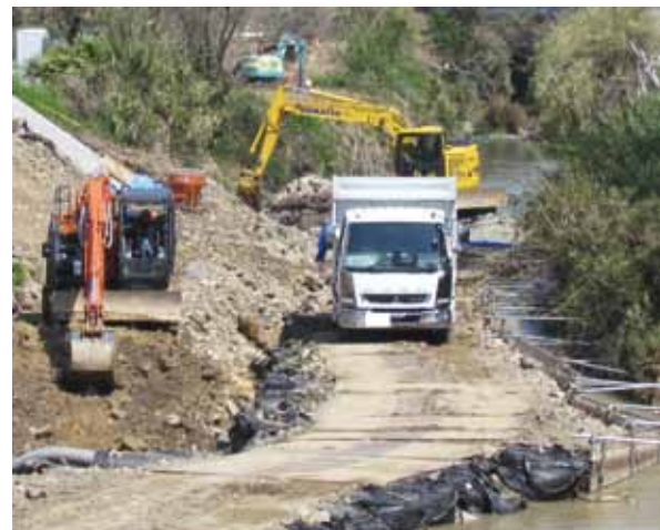
西川の工事現場
