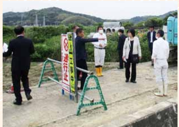
早期完成を待つ町道高家中央線
