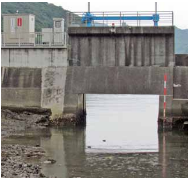
開閉機を修繕する比井漁港の水門
