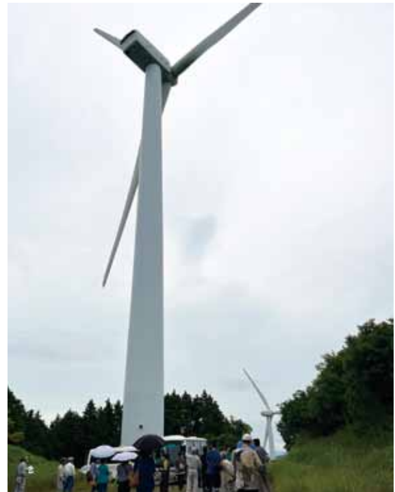
1500kWの既設風力発電機（白馬ウインドファーム）
