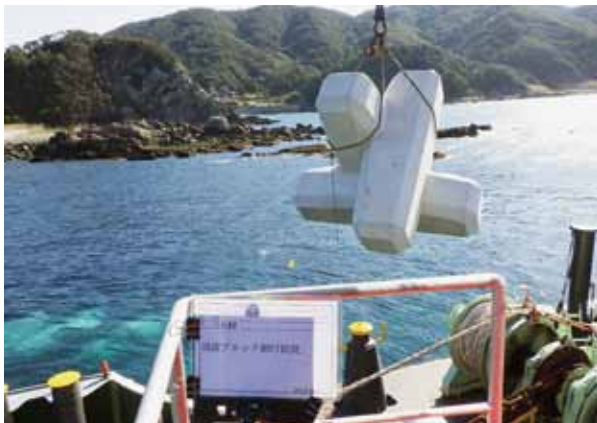
工事中の田杭漁港
