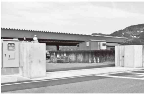
完成した陸閘鉄扉(阿尾地区)
