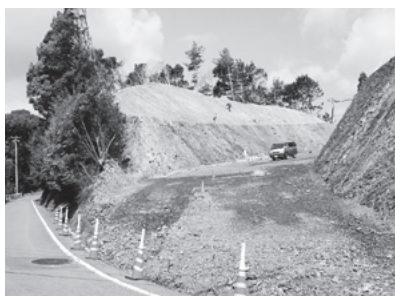
原谷地区で工事が進む県道井関御坊線
