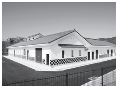
完成した高家下水処理場
