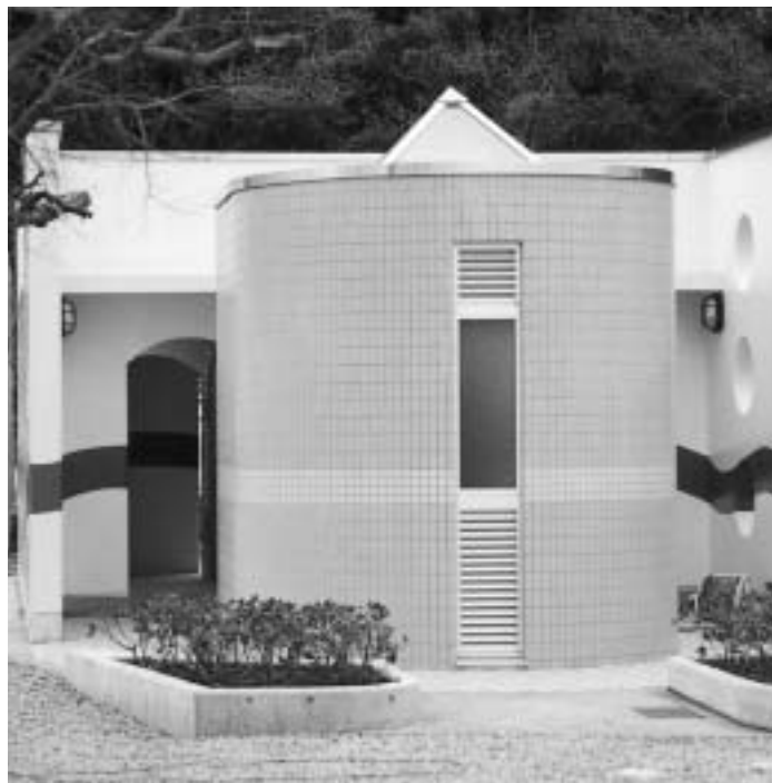
産湯海水浴場公衆便所
