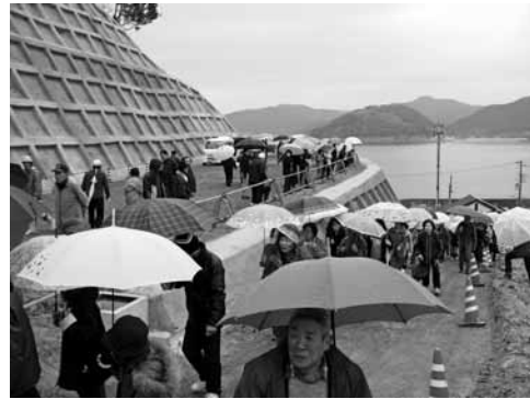
阿尾地区で実施された避難訓練
