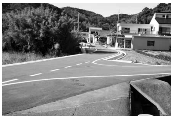
平成28年度完成予定の町道比井小学校川添線
