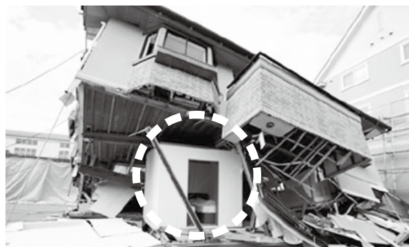
耐震シェルターの一例
