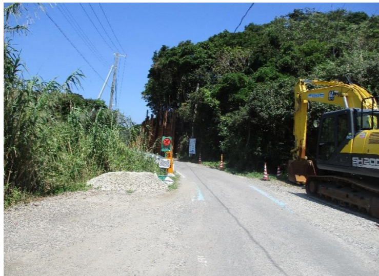
②-1 県道御坊由良線（田杭～阿尾）みちしお付近 幅員が狭く、線形も悪い。 強風により越波が発生する。 （改良工事を実施中）
