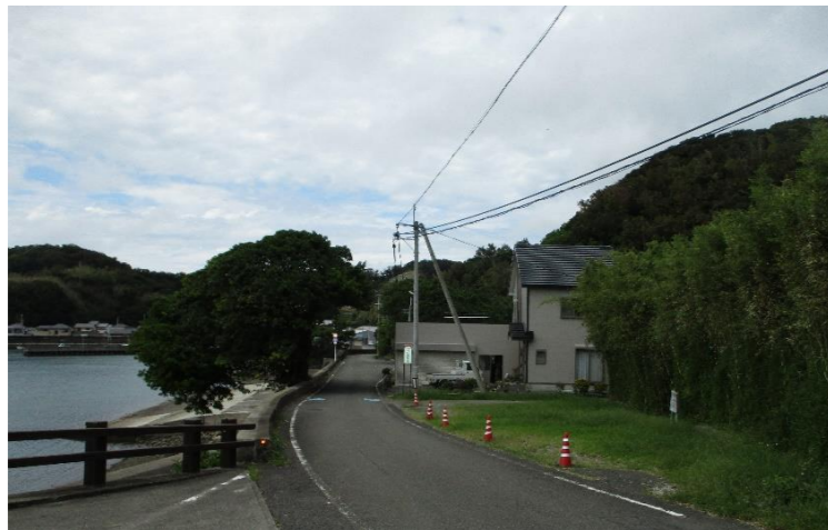
③ 県道御坊由良線 幅員が狭く、歩道と車道の区別がない。
