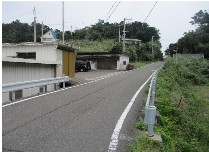
① 県道御坊由良線 田杭・通学バス乗り場周辺 横断歩道がない
