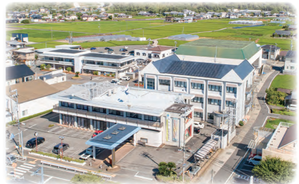
役場庁舎の太陽光発電設備
