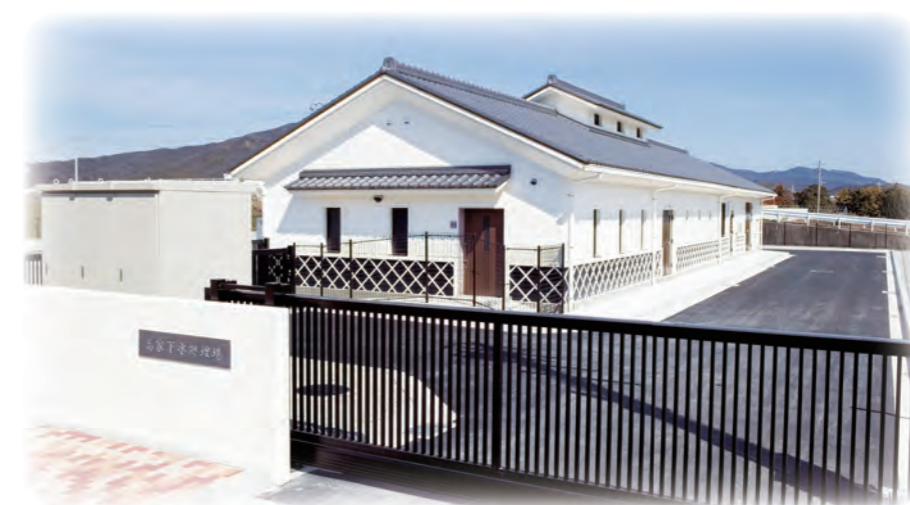
高家下水処理場
