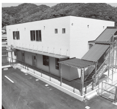
内原小学校特別教室棟の増築
